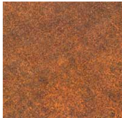
Cortenledning 2 mnd i friluft
